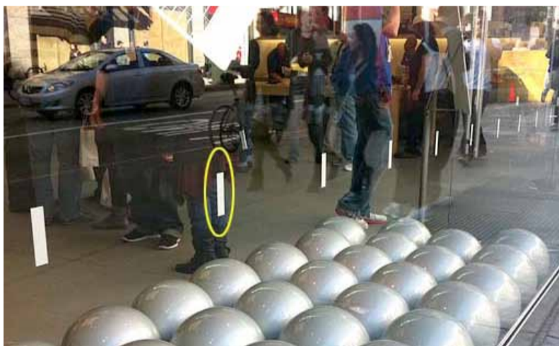
Die weißen vertikalen Striche wurden nun an Apple Store Glasflächen angebracht. Foto: IFOAppleStore
