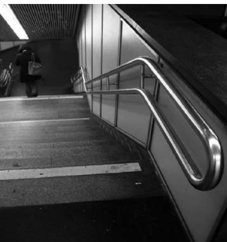
Abb. 2: Wiener U-Bahn - Stufenmarkierung
